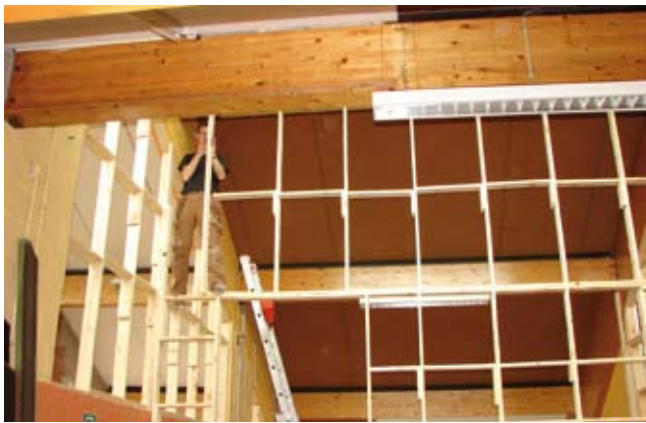
Le chantier à l'intérieur...
